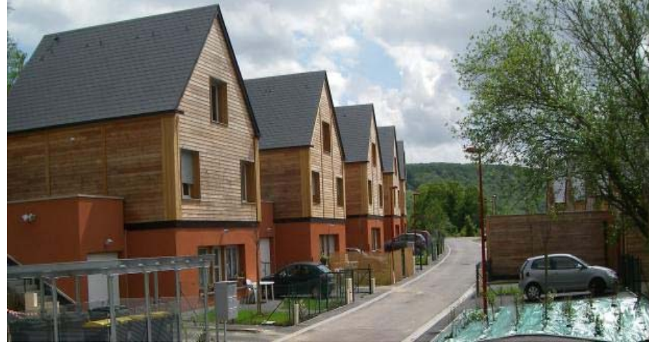
Construction de 20 logements collectifs sur la Commune des Andelys
